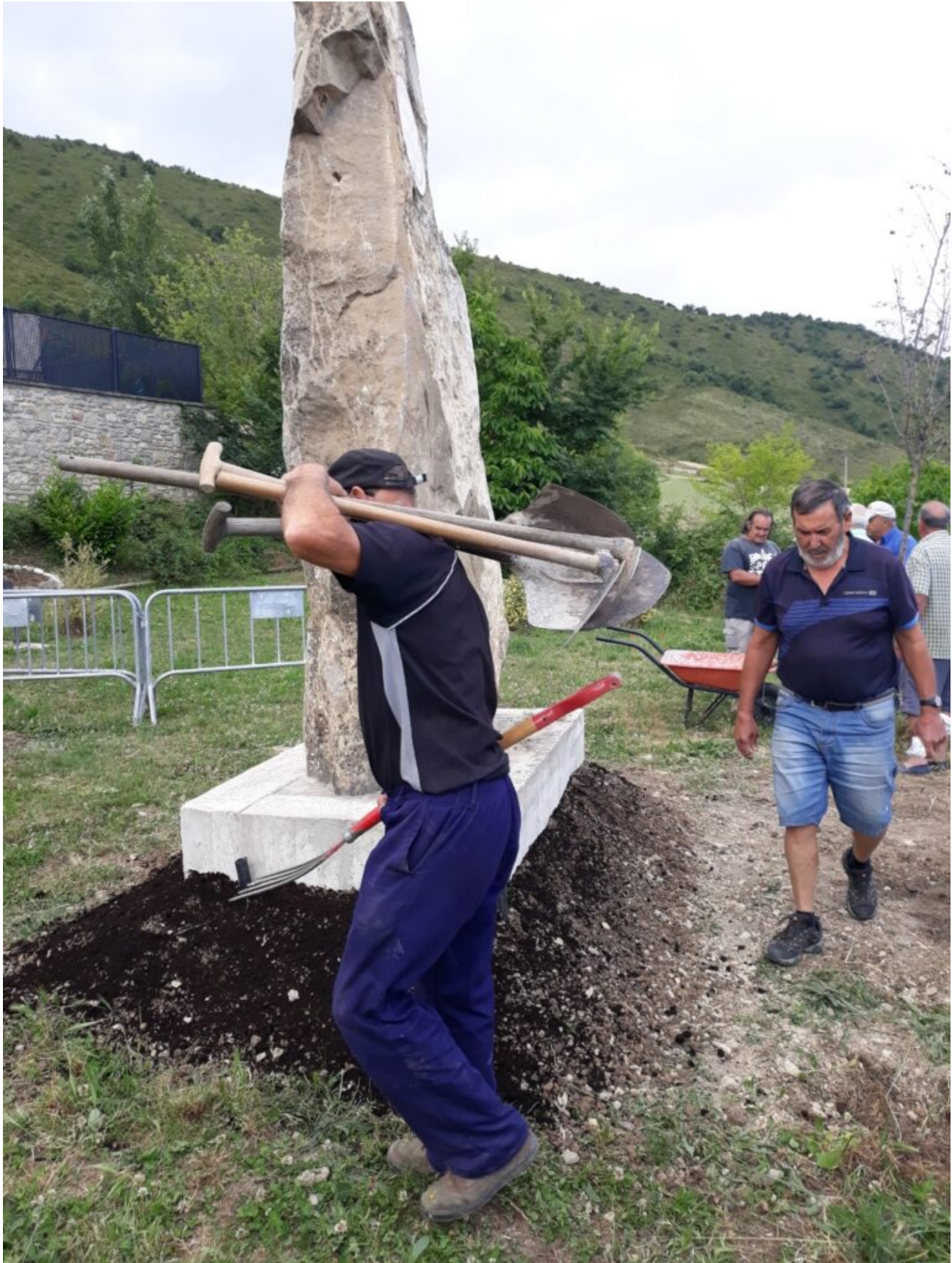
Trabajos para la colocación del monolito monumental en homenaje a Mina en su pueblo natal, Otano.
